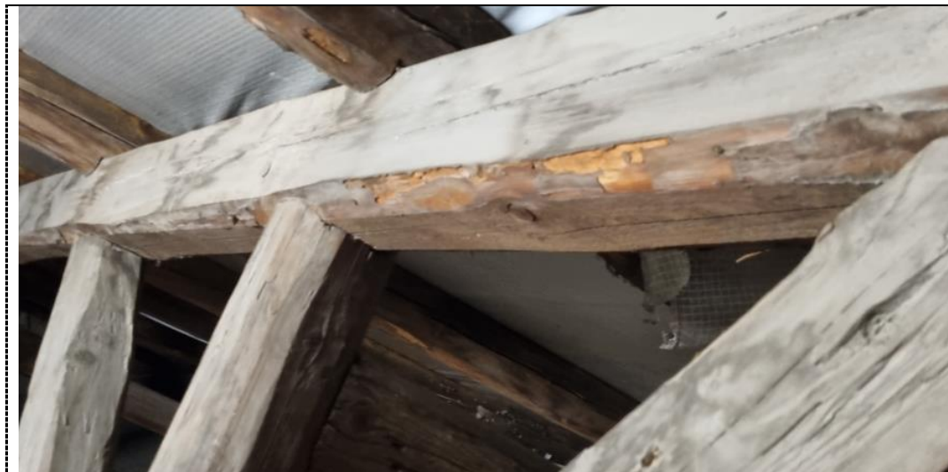
Obr. 20 Počínající napadení biotickými škůdci na dřevěných prvcích pultové střechy
