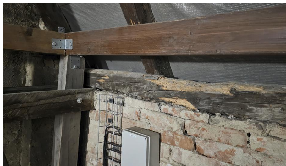
Obr. 6 Pozednice šikmé střechy uliční části objektu napadená biotickými škůdci, neodborně provedený rohový spoj [P1]
