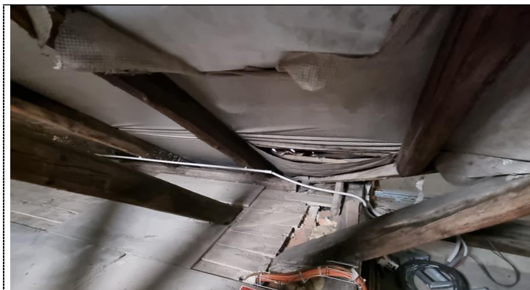
Obr. 19 Porušená pojistná hydroizolace pultové střechy [P1]
