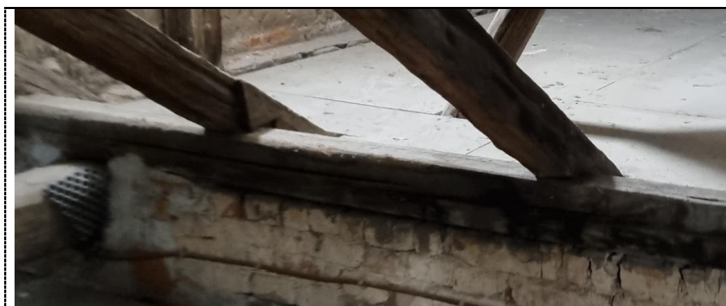
Obr. 22 Krokve osedlané na velkou hloubku [P1]
