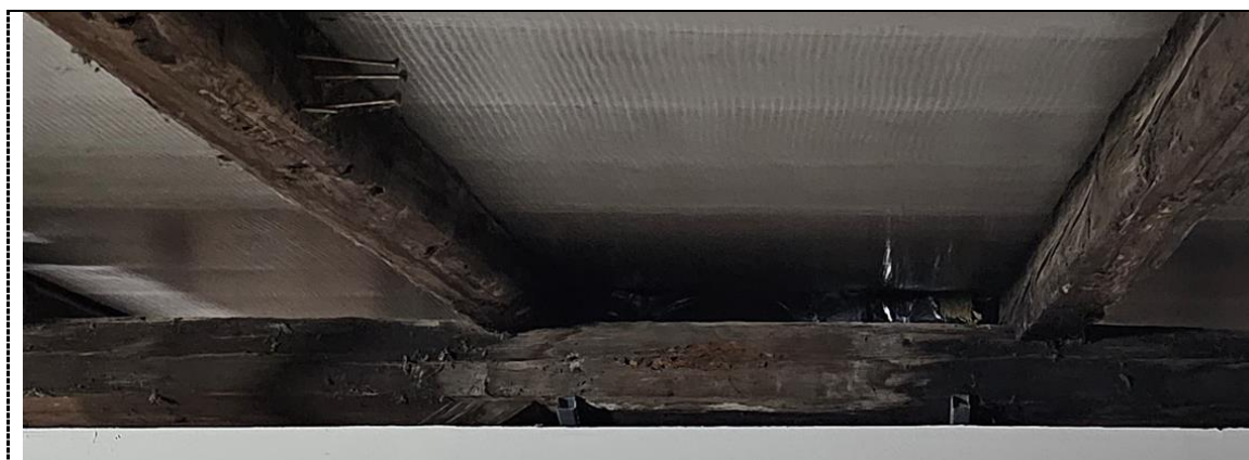
Obr. 23 Pásek napadený biotickými škůdci [P1]
