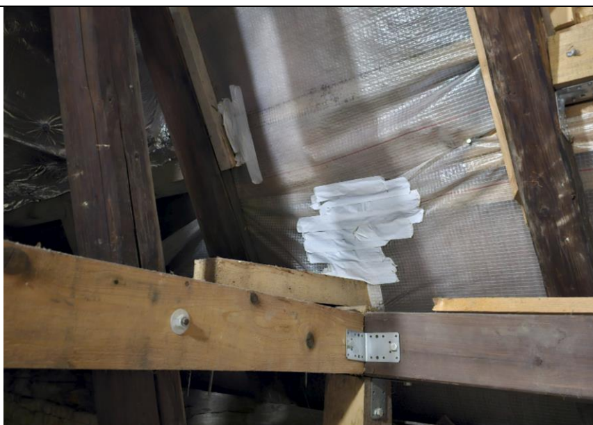
Obr. 15 Rohový spoj a provizorně sanovaná pojistná hydroizolace [P1]
