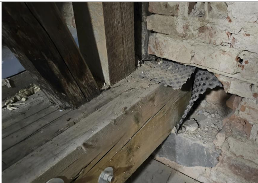
Obr. 14 Uložení vazného trámu [P1]
