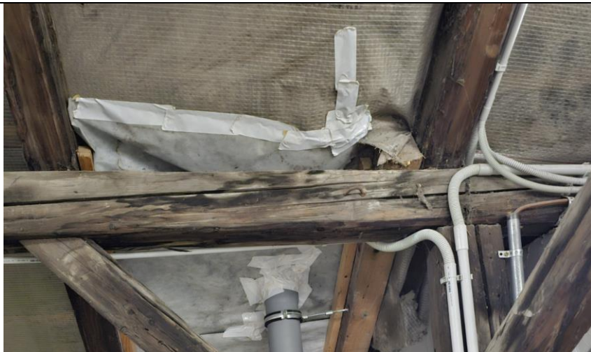
Obr. 11 Pojistná hydroizolace [P1]
