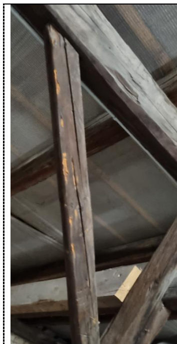
Obr. 23 Pásek napadený biotickými škůdci [P1]
