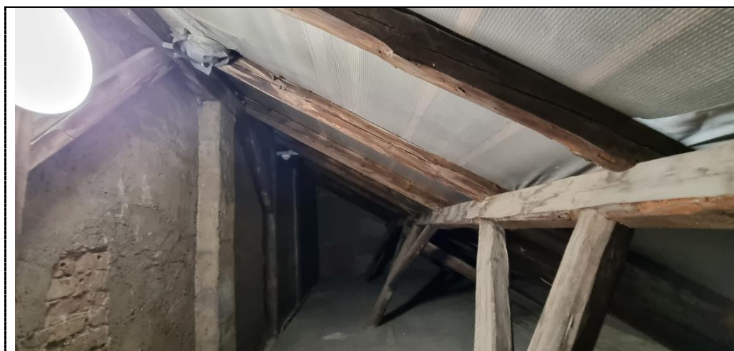
Obr. 17 Neodborně provedený detail spojení krokv/výměna [P1]
