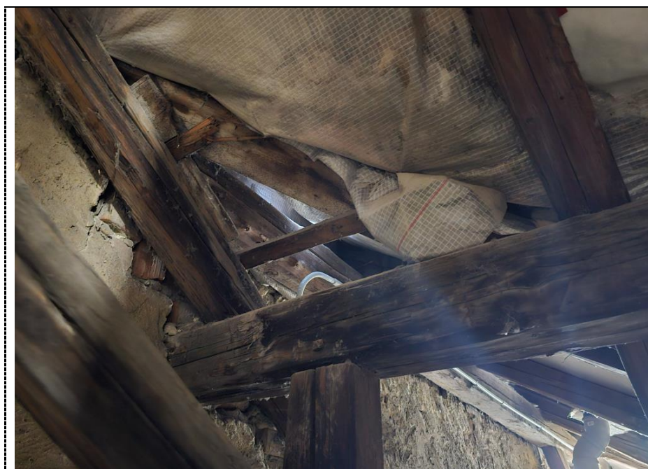
Obr. 21 Pravděpodobné porušení střešního pláště (prosvítání denního světla) [P1]
